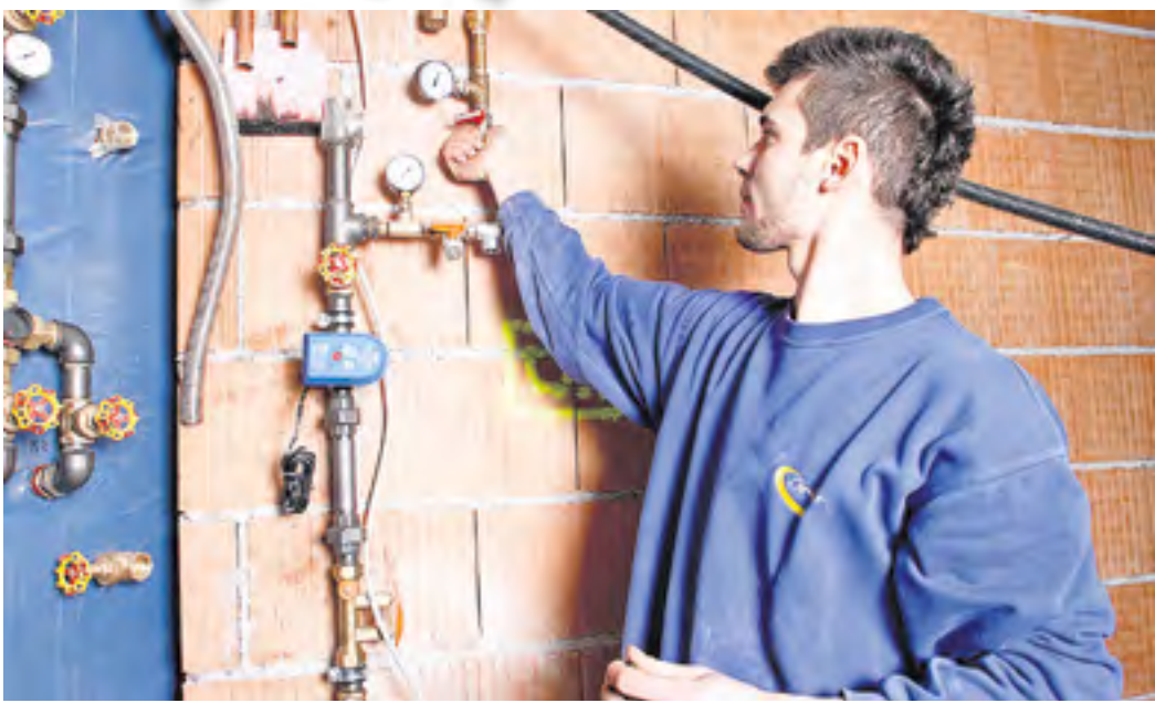
Für den Einbau von Heizungen, die mit erneuerbaren Energien arbeiten, bietet der Staat im Jahr 2020 attraktive Förderungen an. Fotos: djd/Bauherren-Schutzbund
